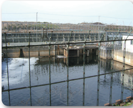
集水池（ポンプ井）
