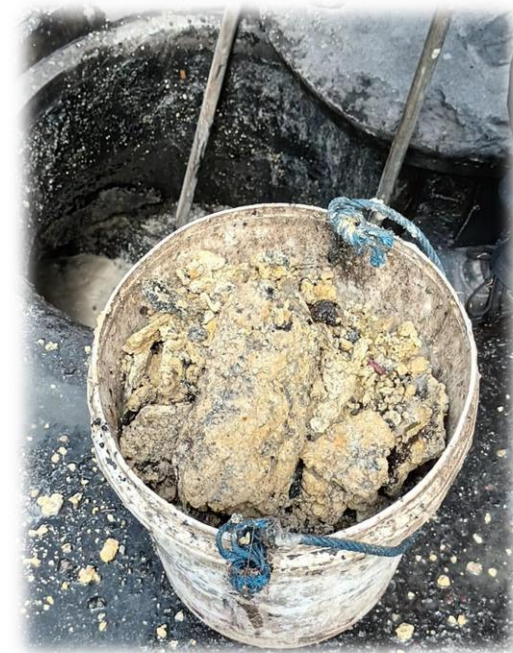
図1 管渠から取り除いた油脂
