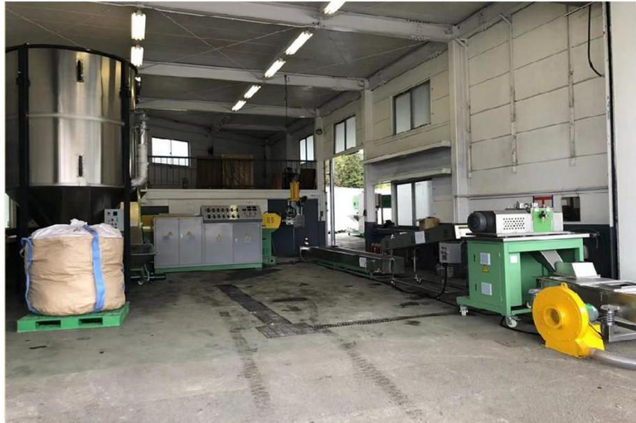
硬質プラスチックリサイクルライン
