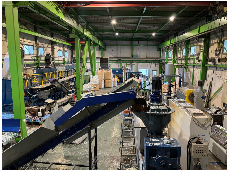
粉碎機・比重分離機・押出機ライン全体
