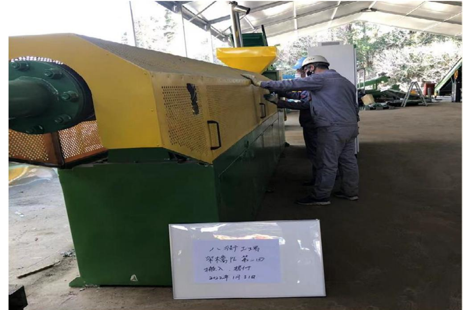
破砕機据付工事
