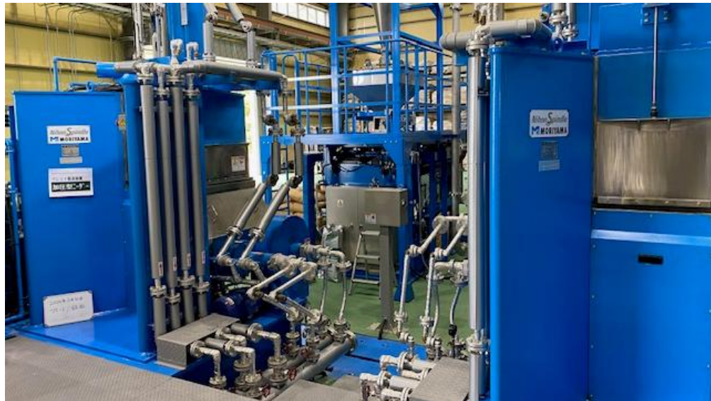
混錬機(加圧型ニーダー)
