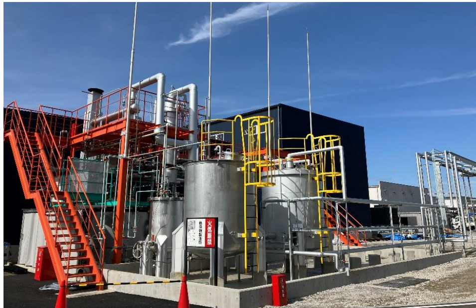
廃プラスチック油化装置（熱分解式 REP10000）
