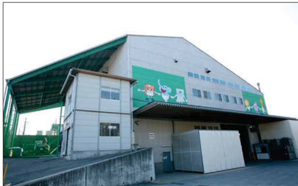
大栄環境(株)三木リサイクルセンター（三木市）
