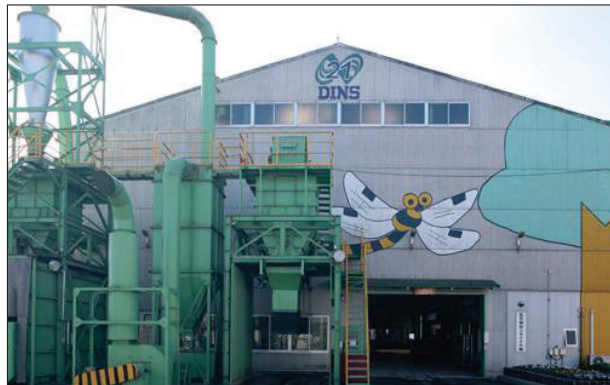
三重中央開発(株)三重リサイクルセンター（伊賀市）
