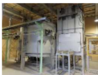
<Li-ion電池リサイクル設備>
