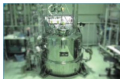
<バイオマスプラスチック製造設備>
