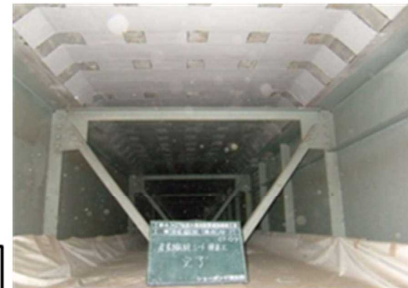
炭素繊維シートの貼り付け
