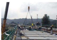
プレキャスト床版による 打ち替え
