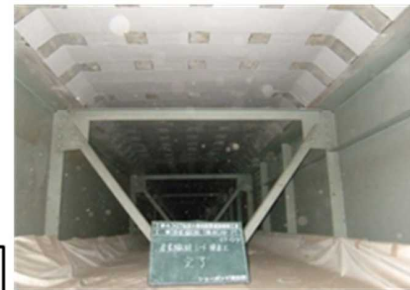
炭素繊維シートの貼り付け
