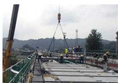
プレキャスト床版による 打ち替え
