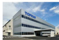
群馬センター工場
