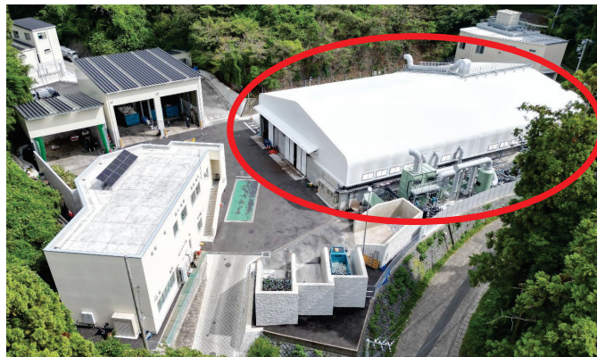
(生ごみ資源化処理施設)
