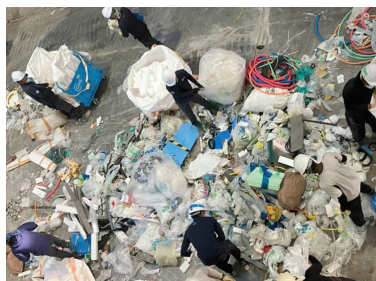
土間選別の作業状況
