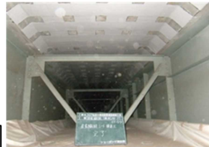
炭素繊維シートの貼り付け
