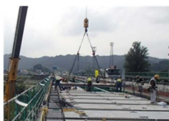
プレキャスト床版による 打ち替え
